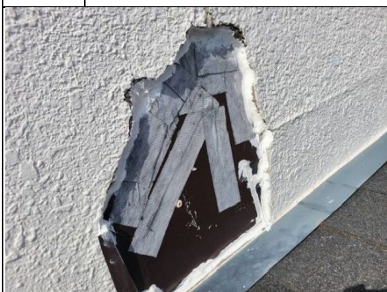
解体部復旧（防水テープ貼り）
