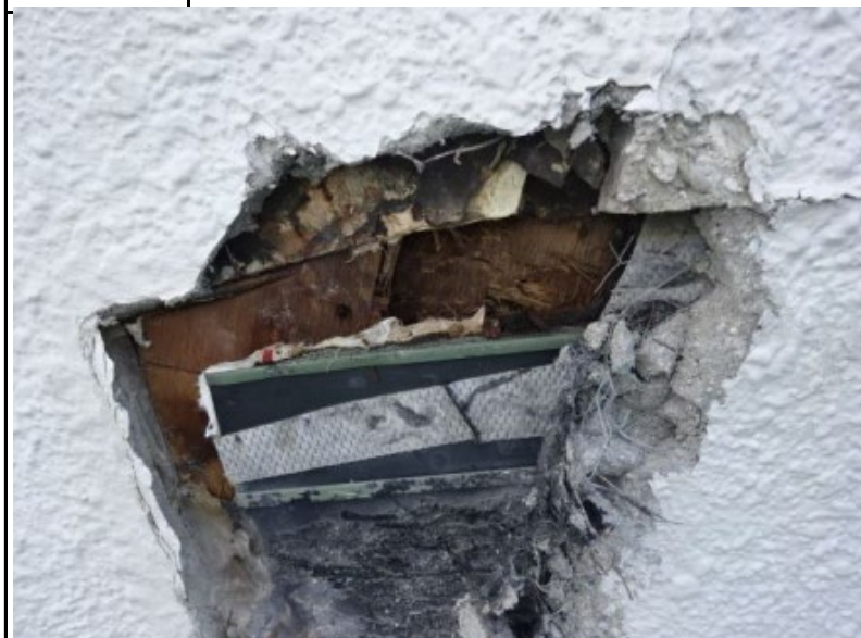
壁解体部拡大
