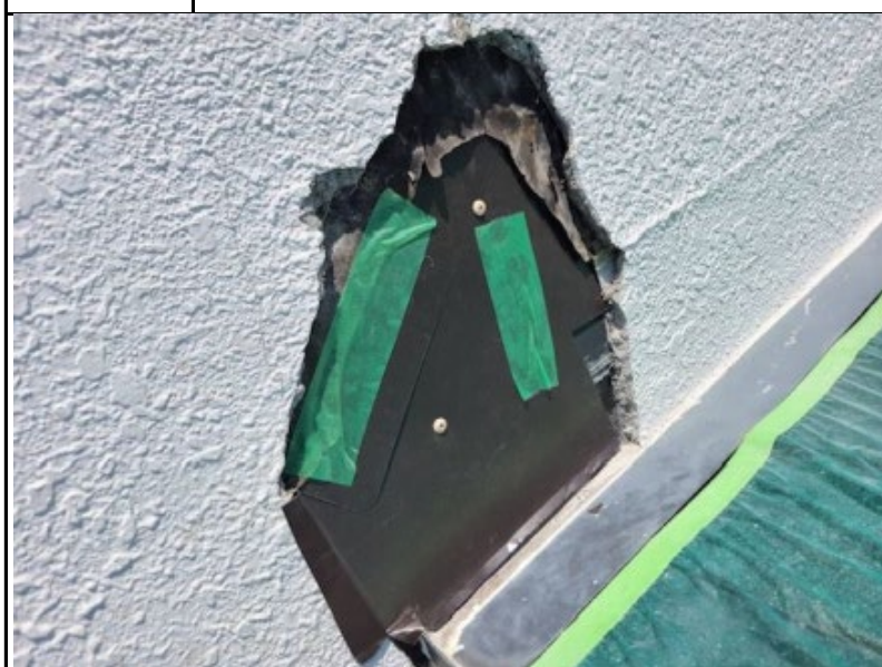
解体部復旧（鉄板貼り）
