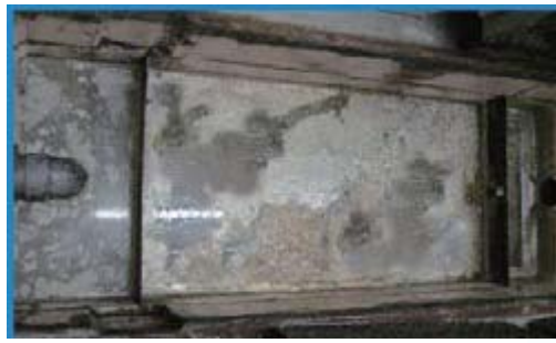
例) 食品関係グリストラップの使用後の配管例
